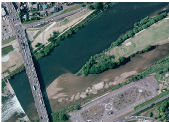
図3 検証箇所 (庄内川: 愛知県)
