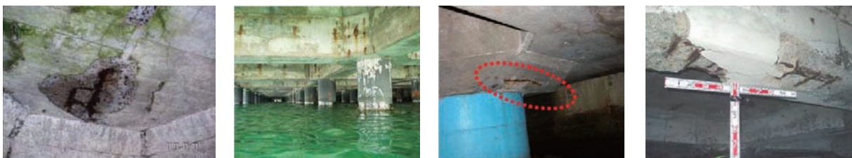
図3 損傷箇所の現地確認の状況
