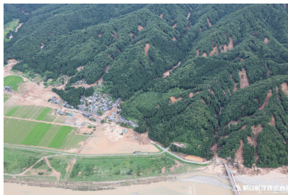
図1 令和4年8月出水時の状況（新潟県村上市小岩内地区）
