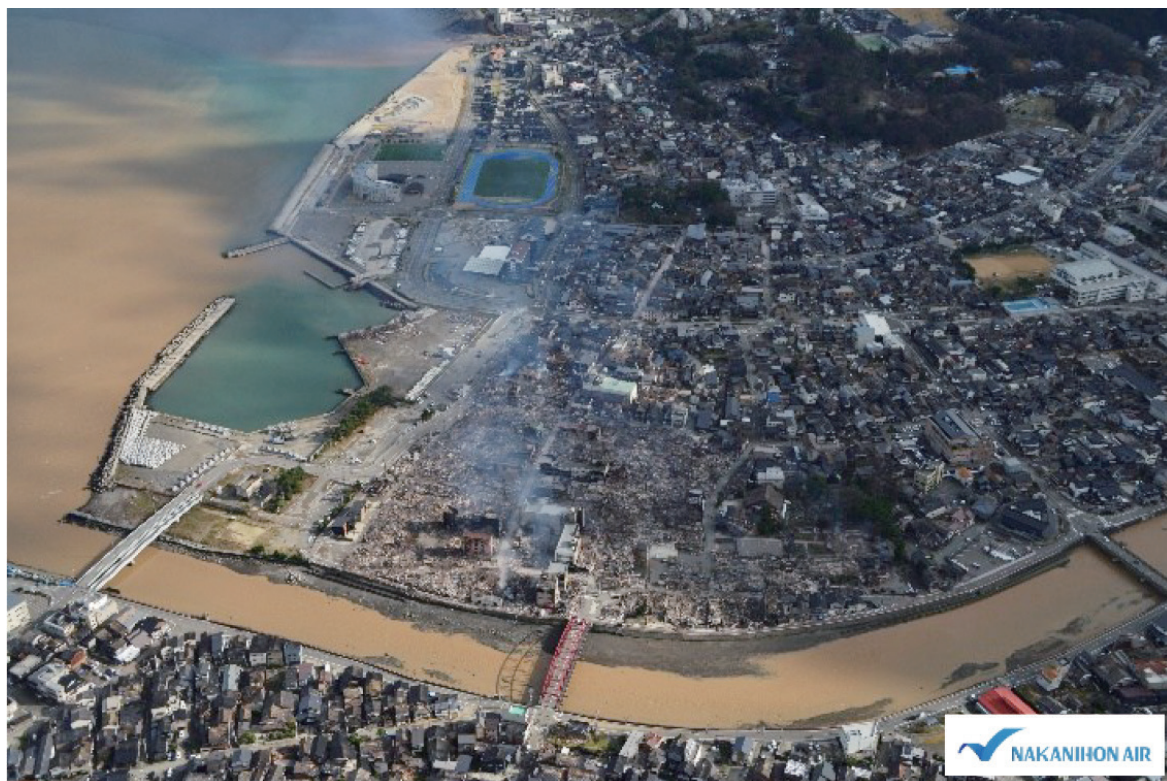
図1 被災後火災の発生した輪島市内
