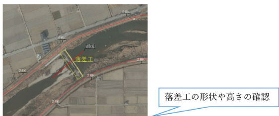
図14 落差工の航空写真
