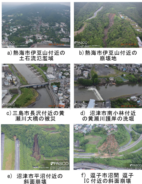
図3 航空機による被災状況の斜め写真例 5)
