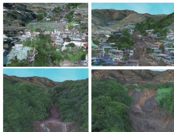
図9 ドローン計測による3次元表示例
