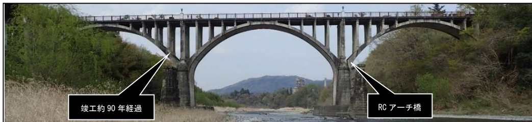
図1. 計測対象橋梁
