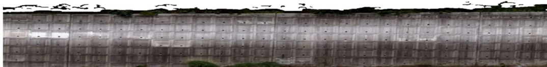
図 4 SfM 解析後の法面オルソ画像
