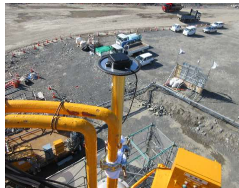
図 3 アンテナの設置状況
